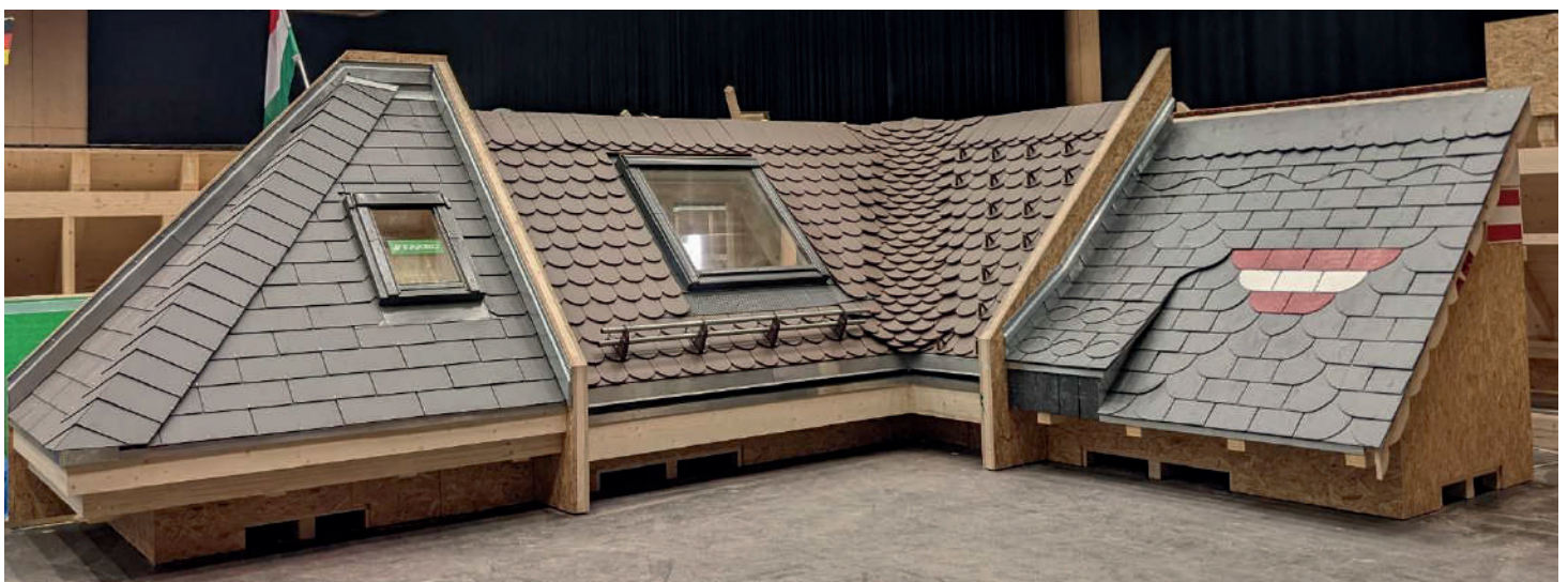
Weltmeisterschaft der Dachdecker in St. Gallen (CH): Fertiggestelltes Gewerk von J. Latzenhofer
